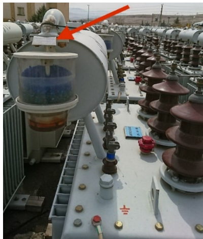
شکل ۸-۲۱- قطعه مسدود کننده رطوبت‌گیر
